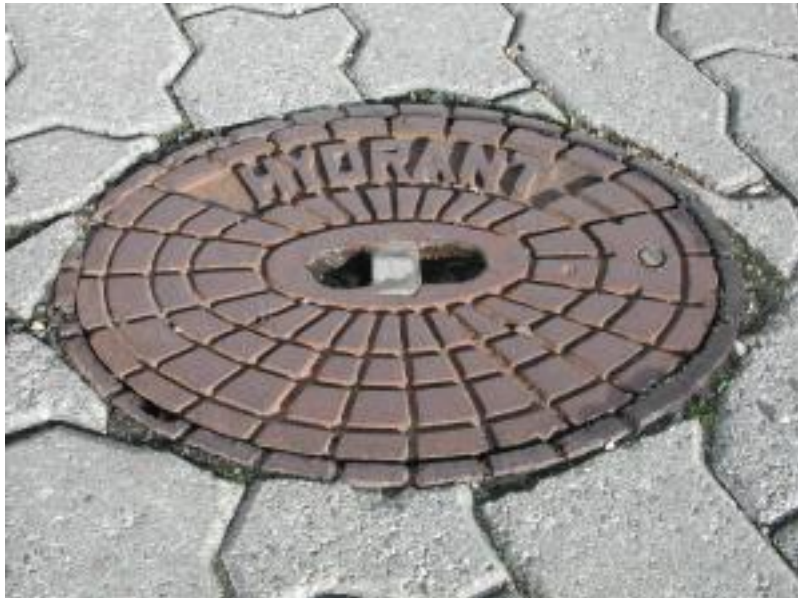
Bild eines Unterflurhydranten
